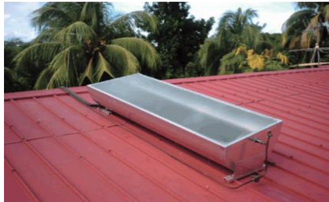
Figure III.8 : Chauffe-eau « autostockeur », Web03.
