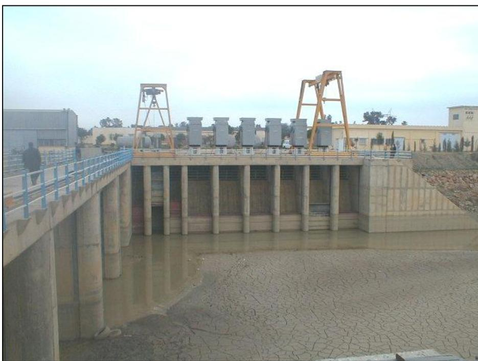
Figure 4 -21: Ensablement de la station de pompage de Boulefred sur l'Oued Sly.
