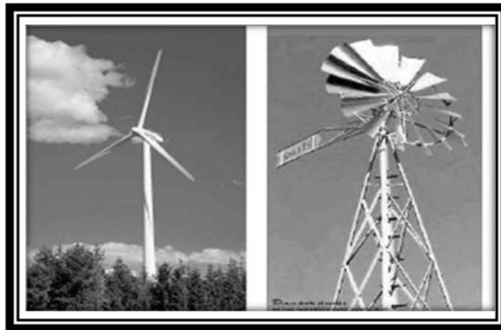
**Figure II.15:** Éoliennes à axe horizontal.
