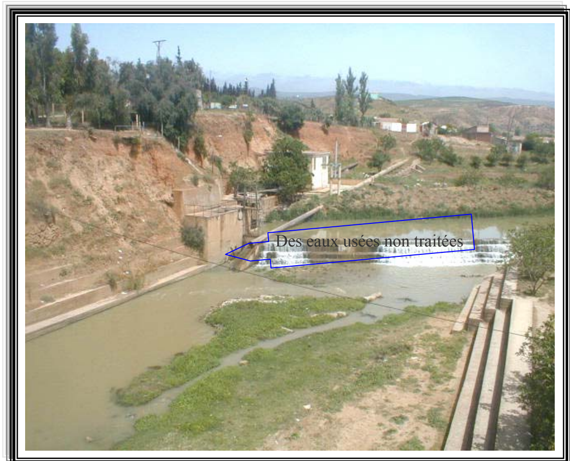
Fig N°III 8 : Les eaux usées rejetées à l'état brut directement ou par affluent dans l'oued Cheliff augmentant ainsi le taux de nitrates.
